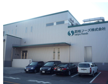
平成24年9月稼働の本社工場
