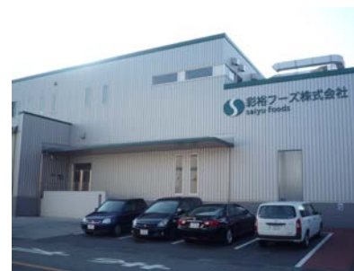
平成24年9月稼働の本社工場
